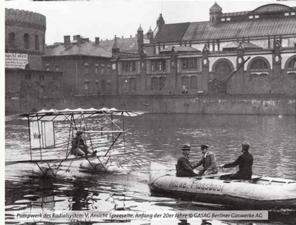
Kesselhaus Pumpwerk des Radialsystem V, 1925 © Berliner Wasserbetriebe
